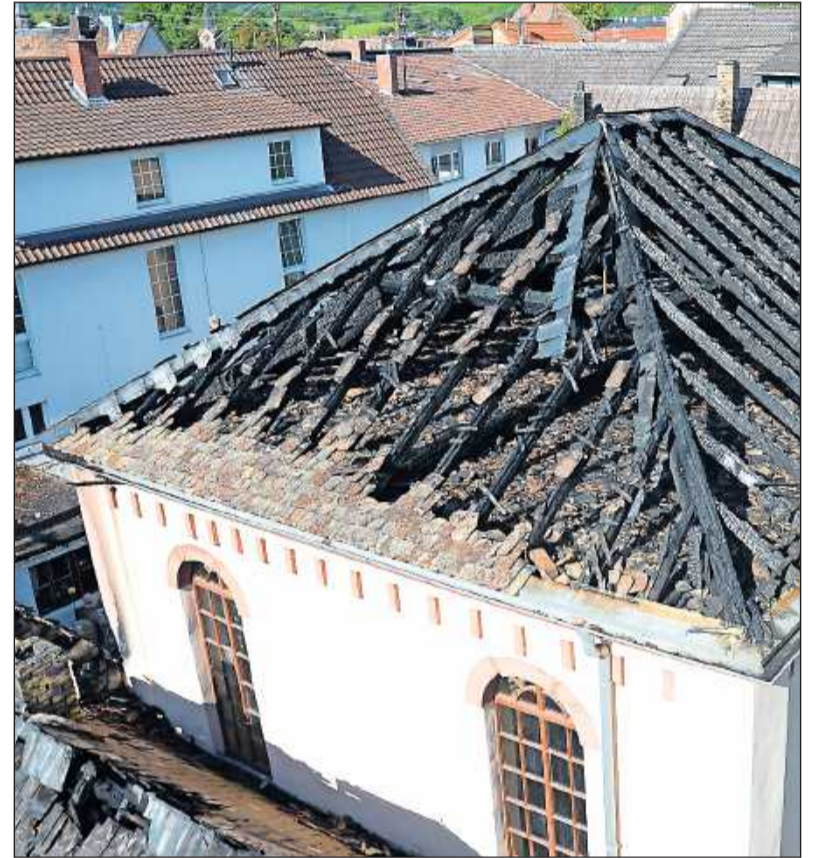
So sah sie nach dem Brand am 21. August aus: Das Feuer hat den Dachstuhl des denkmalgeschützten Gebäudes völlig zerstört. FOTO: LM
