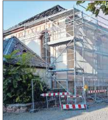
Die alte Synagoge ist derzeit komplett eingerüstet. FOTO: LM
