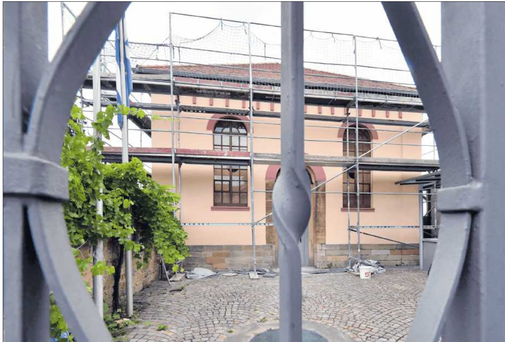
Das Dach der ehemaligen Synagoge ist erneuert, die Fassade gestrichen: Die jetzt noch ausstehenden Arbeiten sollen im Juli abgeschlossen sein, meint Benedikt Reber, zuständiger Mitarbeiter bei der Deidesheimer Verbandsgemeindeverwaltung.
