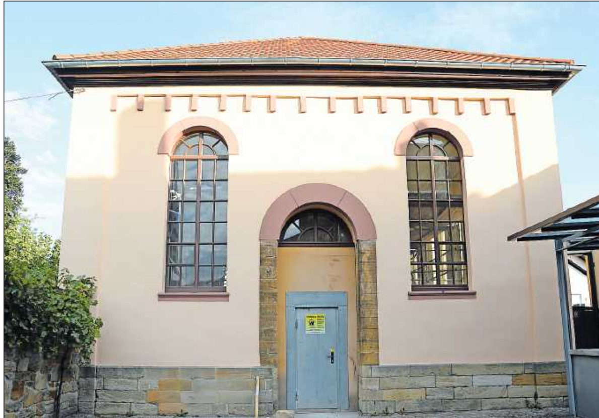
Die provisorische Bautür soll in Kürze wieder durch das Original ersetzt werden.
